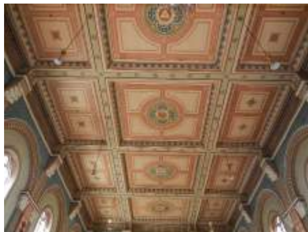
Plafond de la nef
