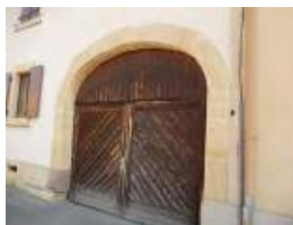
STUDER 3, Rue de l'église Ancienne maison des sœurs garde-malades de 1907 à 1968, en grès jaune
