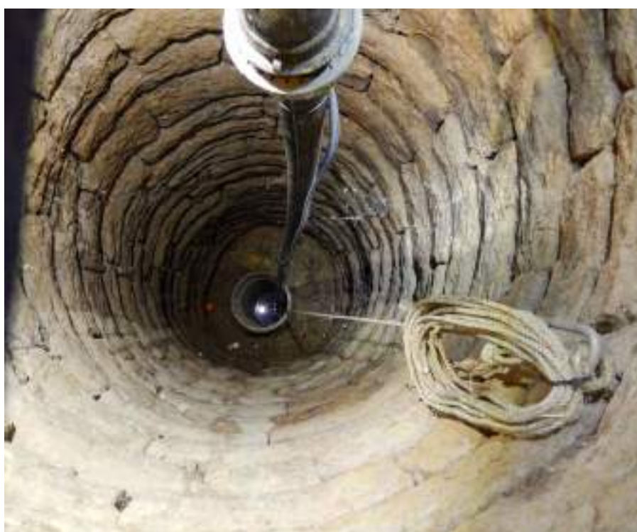
Puits HECHINGER, 2,rue des Herbes
