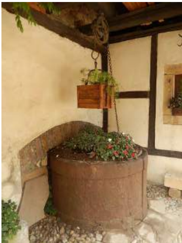
Ferme ZWIEGELSTEIN, 1, rue de Sainte Croix en Plaine Puits non remblayé, couvert
