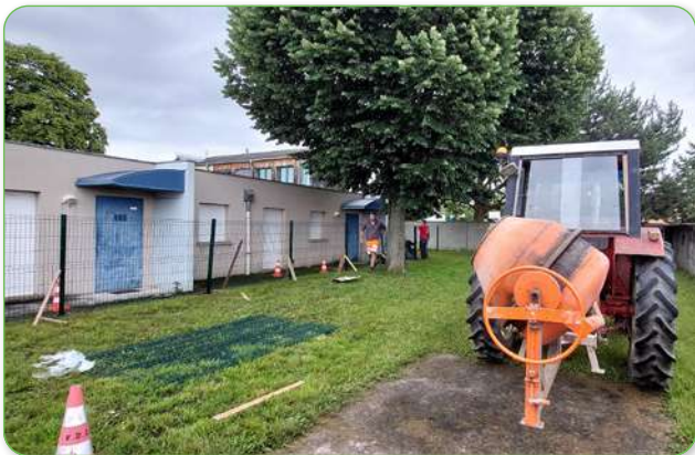
Installation d'une nouvelle clôture
