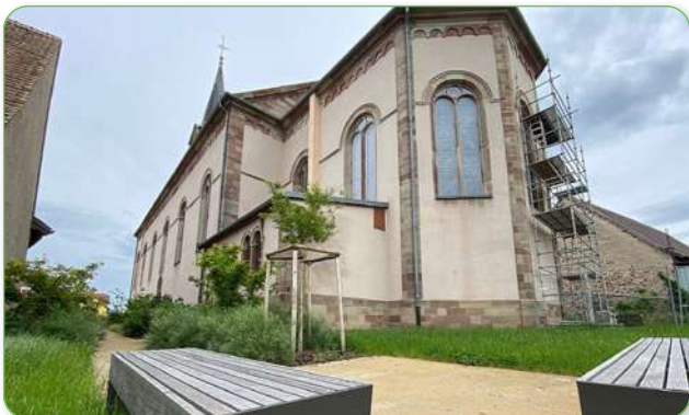
Remplacement des pierres de taille autour des vitraux
