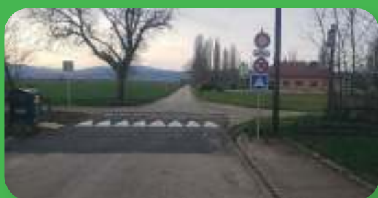
DOS D'ÂNE DE LA RUE DE LA GARE
