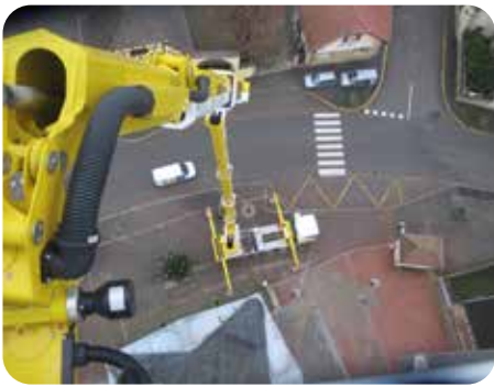
Réparation du clocher
