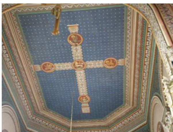
Plafond du chœur
